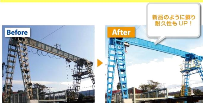
クレーンの錆が進行し、そろそろ塗装を考えていました。錆の浸食、経年劣化のことを考えると通常の塗装ではなく、強度を上げるような塗装を考えていました。そこで防錆・補強コーティングを実施！**一部剥がれかけてたクレーンの土台も補強**することができ、安心して使用できます。今後10年間は心配がなさそうです。
